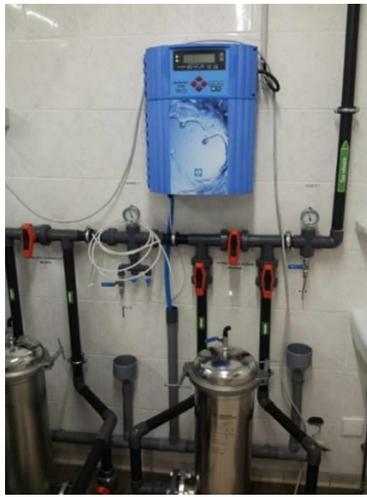
Figure 11 : Filtre charbon actif et Testomat
