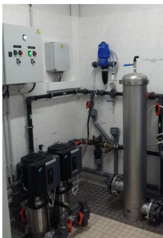
On part de l'eau de ville qui passe dans un surpresseur pour adapter la pression en sortie et avoir toujours la même (il peut être aussi utilisé pour limiter la perte de charge qui correspond à la dissipation de l'énergie mécanique en chaleur).
