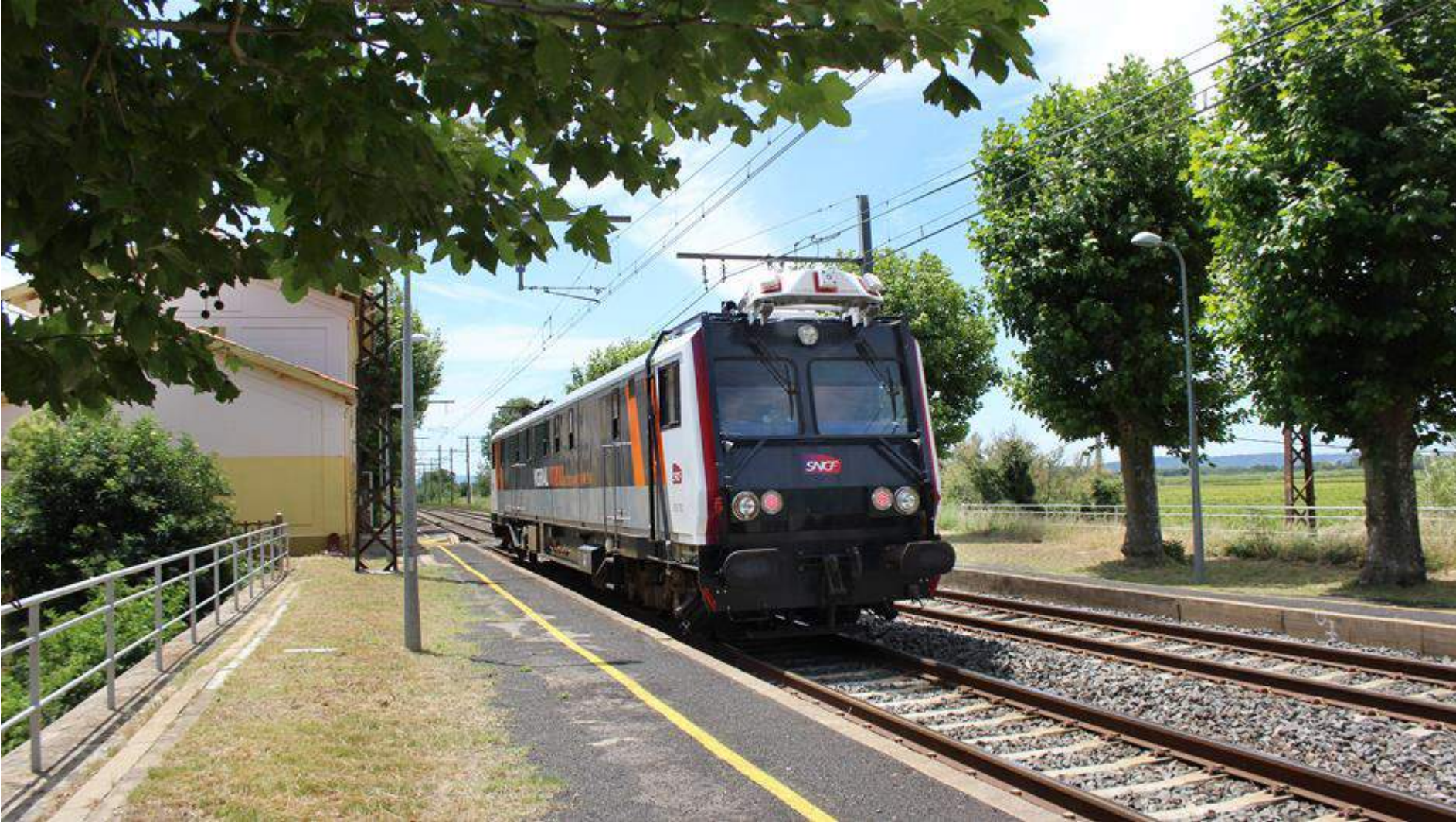
ESV702, faisant partie du groupe des ESV circulant sur toute la France, 7j/7. Auscultation de la voie, données Lidar (environnement de la voie végétation)
